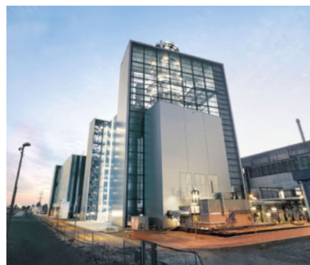
Herzstück der Anlage ist die extrem leistungsfähige Gasturbine SGT5-8000H. ○
