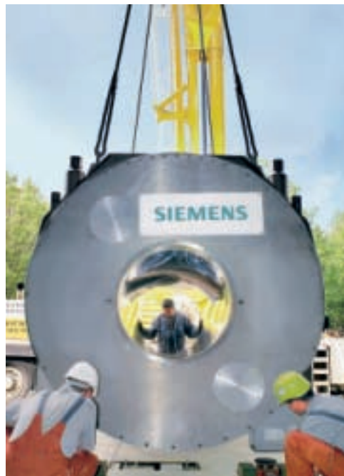
MAGNET für einen 7-Tesla-MRT, wie er in der MedUni Wien installiert wird.
