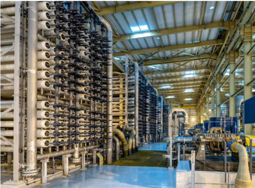
In den Modulen (linke Seite) befinden sich aufgewickelte Membranen, über die das Wasser fließt und durchdiffundiert.
