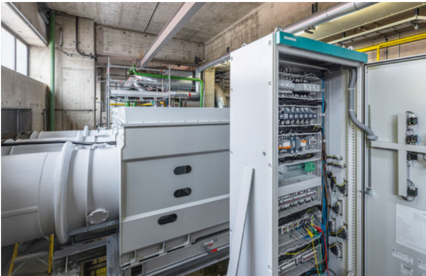
Rechtes Bild: Ansicht des an den Generatorleistungsschalter angeschlossenen Transformators. Unten der Schalter samt Steuerschrank – üblicherweise nicht räumlich getrennt.
