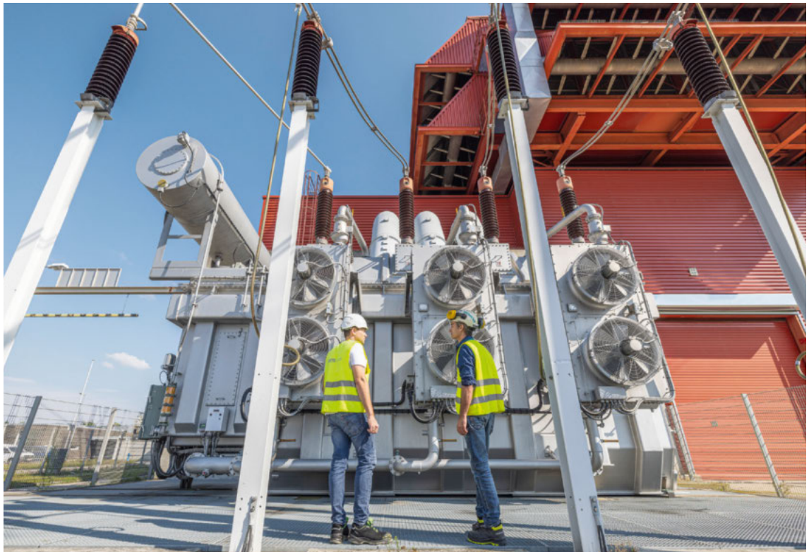
Rechtes Bild: Ansicht des an den Generatorleistungsschalter angeschlossenen Transformators. Unten der Schalter samt Steuerschrank – üblicherweise nicht räumlich getrennt.
