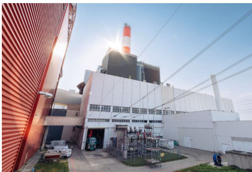
Kalarisches Kraftwerk Theiß: Mit 800 MW Nennleistung das leistungsstärkste und zugleich größte Kraftwerk der EVN AG.
